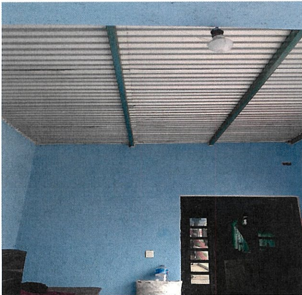
Construcción de Techo Firme, Ejido Galeana
