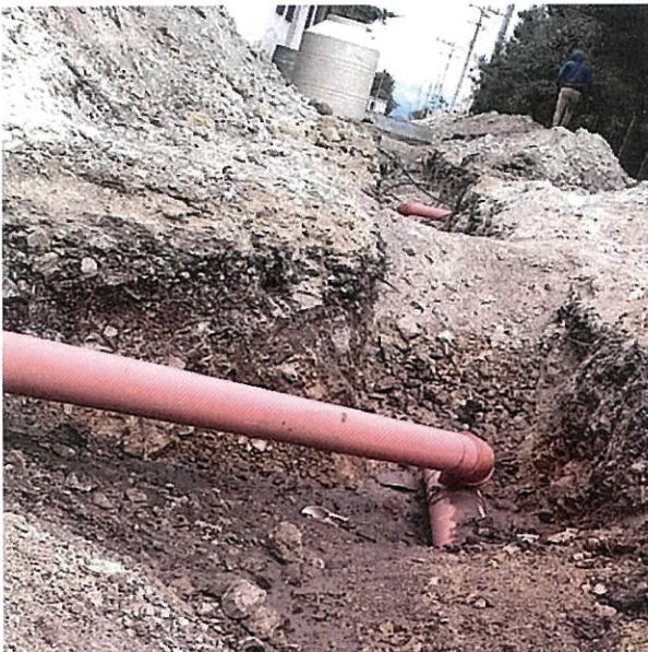
Ampliación de red de drenaje sanitario, Barrio 5 de Mayo
