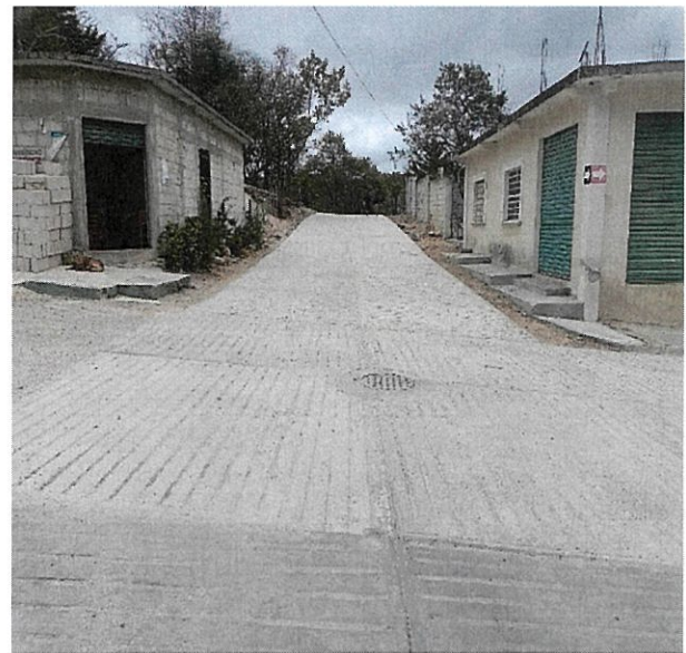
Pavimentación de Calles con Concreto Hidraulico, Barrio 5 de Mayo, La Independencia
