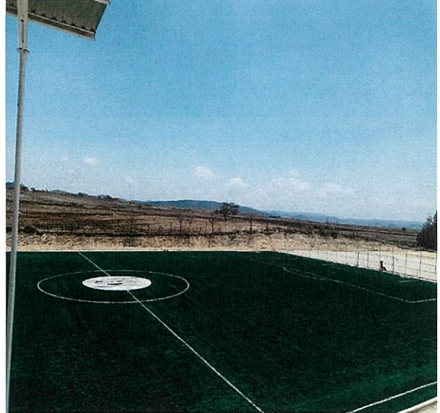
Construcción de Unidad Deportiva Pública 2ª. Etapa, Anexo Buena vista
