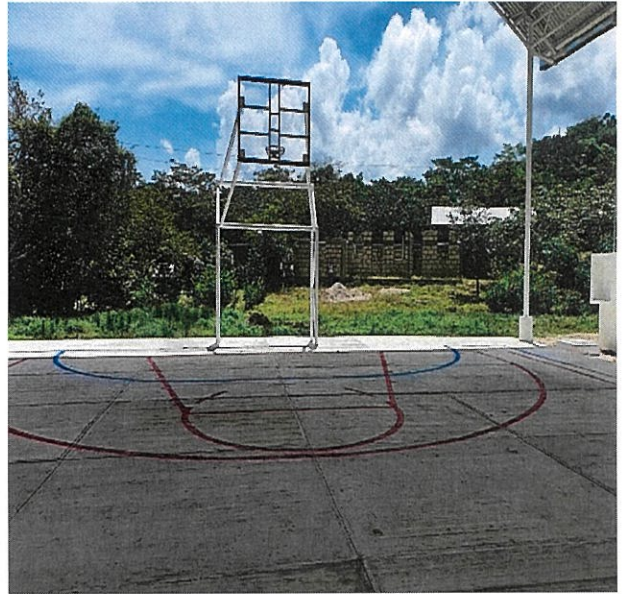
Construcción de Cancha de usos múltiples en la Escuela Primaria "Cursos Comunitarios" con Clave:07kpr14546, En Ranchería Nuevo Mundo el Naranja
