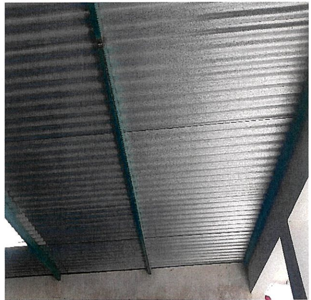
Construcción de Techo Firme, Ejido Ojo de Agua
