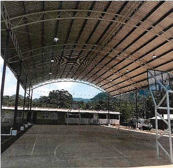
Construcción de Techado en áreas de impartición de Educación física en Escuela Primaria "Octavio Paz" con Clave:07db2982u, En Ranchería la Unión.
