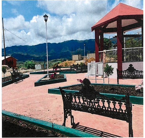
Construcción de Parque Público, Ejido Nuevo Tenejapa
