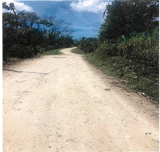
Revestimiento de Camino, Ejido Nuevo Pinar del Río
