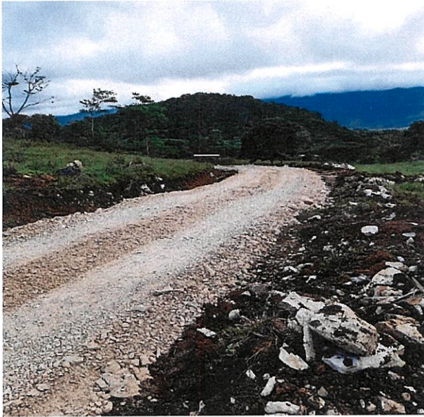
Revestimiento de Camino, Ranchería Los Espinos
