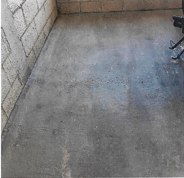
Construcción de Piso Firme, Ejido Galeana
