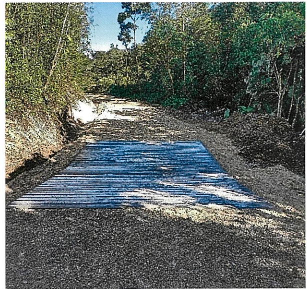
Apertura y Revestimiento de Camino Sacacosecha, en ejido Tierra y Libertad
