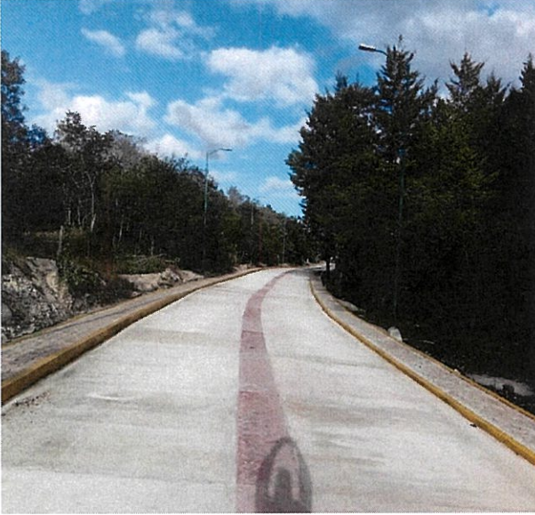
Pavimentación de Calles con Concreto Hidráulico, Barrio 5 de Mayo
