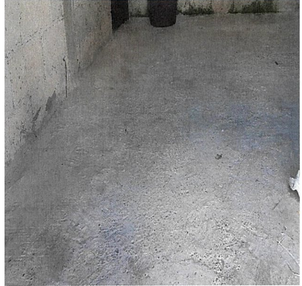
Construcción de Piso Firme, Ejido Emiliano Zapata
